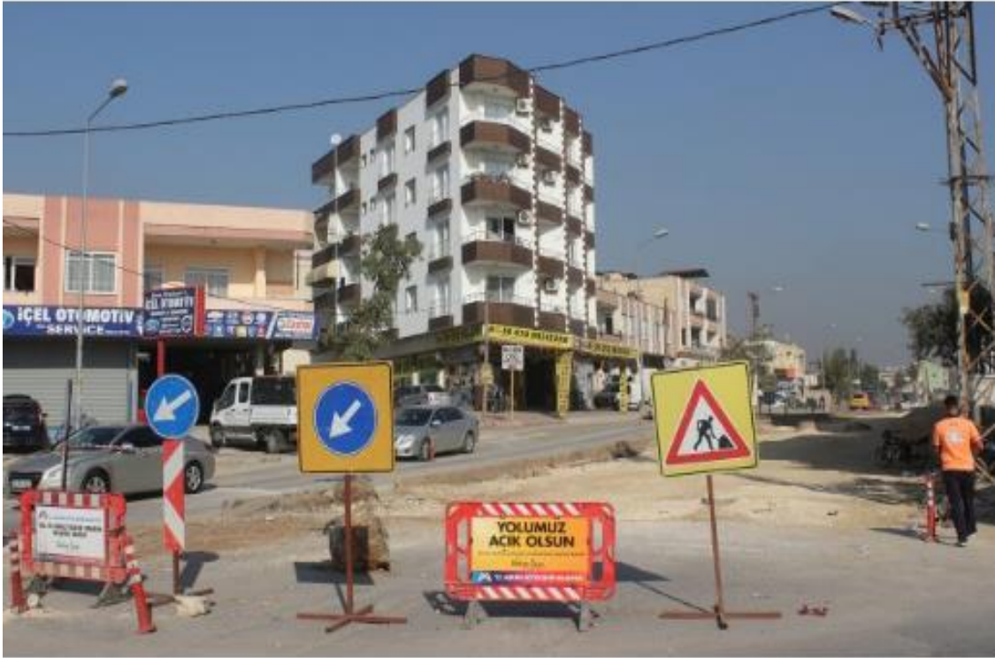
BÜYÜKŞEHİR'DEN YALINAYAK MAHALLESİ'NE ÜST YAPI ÇALIŞMASI
